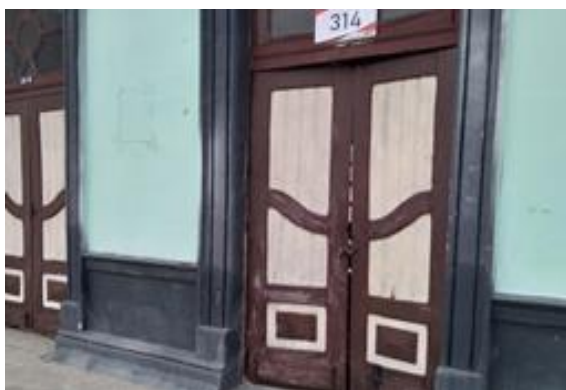
Figura 51. Deterioro elementos de madera(puertas)
