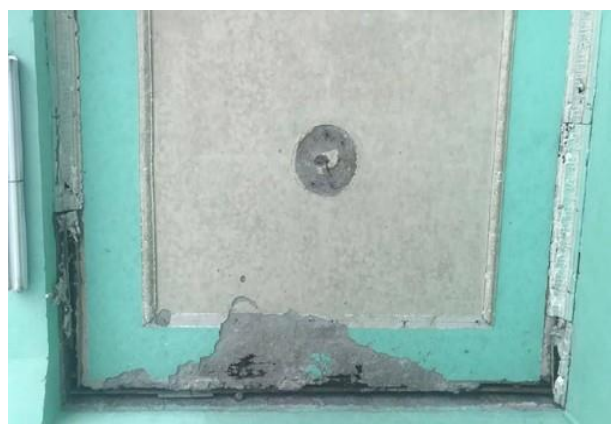
Figura 41. Desprendimiento de revestimiento (techo)
