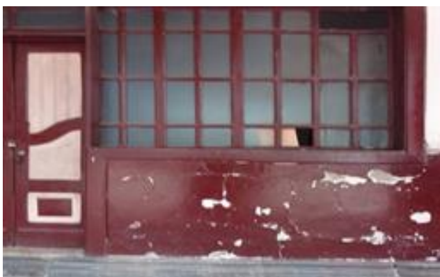
Figura 45. Erosión (muros)
