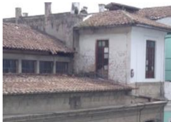
Figura 49. Desprendimiento de elementos (techo)
