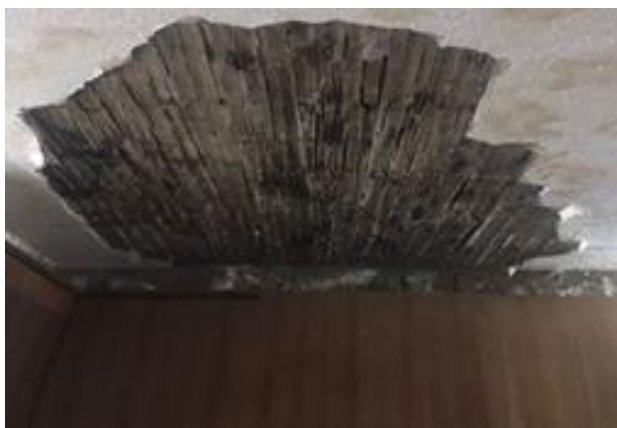
Figura 41. Desprendimiento de revestimiento (techo)
