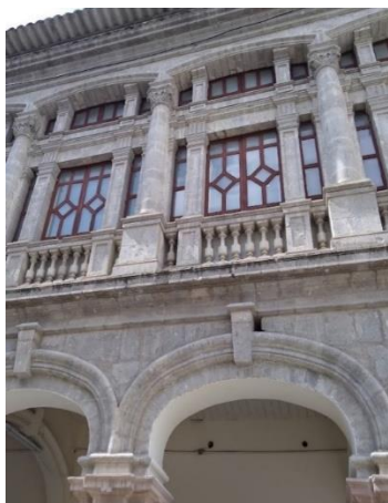
Figura 30. Fachada Lateral Derecha Interior del Colegio Nacional Bolívar
