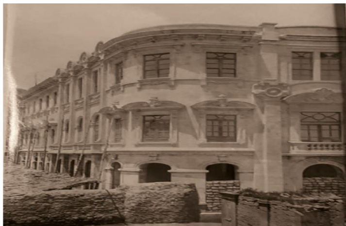
Figura 14. Construcción del Colegio Nacional Bolívar 1927
