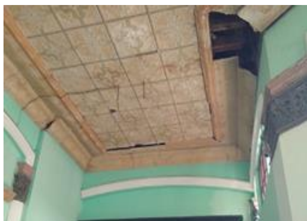
Figura 49. Desprendimiento de elementos (techo)
