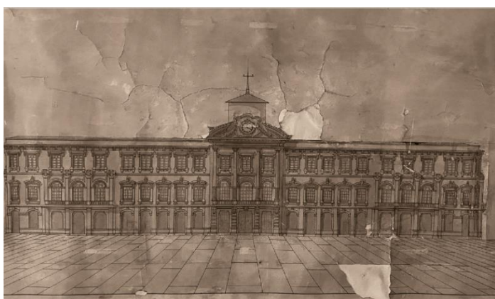
Figura 13. Reconstrucción del Colegio Nacional Bolívar 1925
