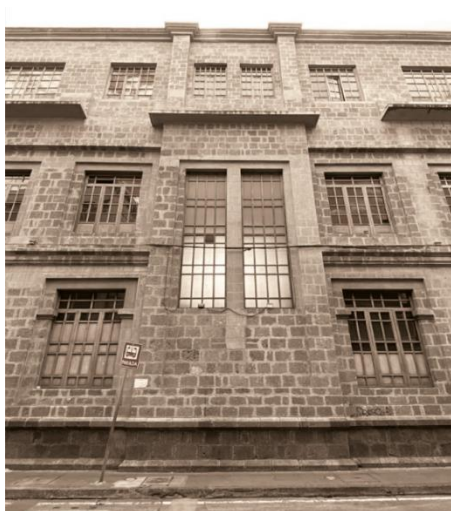
Figura 23. Fachada Colegio Nacional Bolívar
